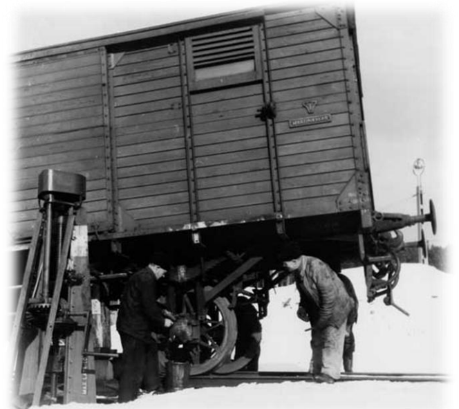
Vagnslyftare i arbete, årtal okänt.
